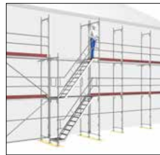
Bild 59: Montering av gavelräcke
