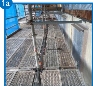
Vid ställning med innerkonsol justeras innerkonsolen vid bomlagshöjningar.
