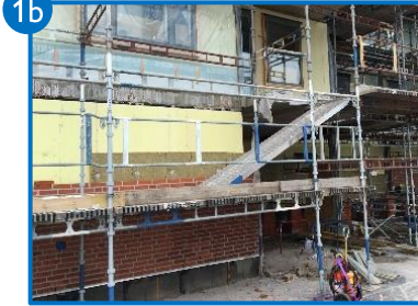
Vid Hakiställning justeras hela bomlaget vid bomlagshöjningar.
