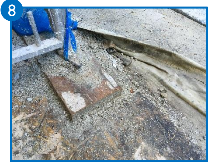
Mark under ställning skyddas med geotextil eller likvärdigt så att restavfall från fasadarbeten ej blandas med underliggande material.
