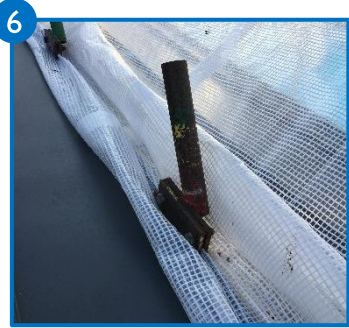
Vinterväv som fästes på plåttak kläms i falsen med falsfästen.
