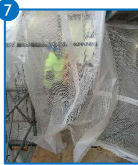
Skiljeväggar byggs inom ställning för avgränsning av uppvärmda ytor, gäller vid vinterväv/plast.
